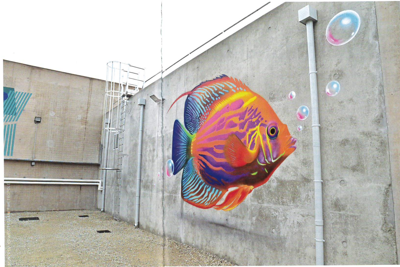
Les murs de la centrale ont été peints par les artistes de l'association L'Or des murs.
